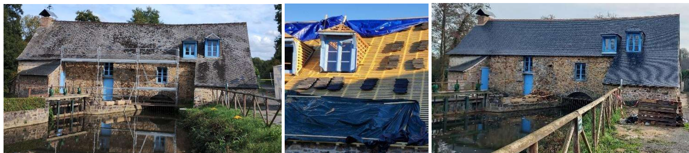
Une couverture neuve qui valorise fortement le site
