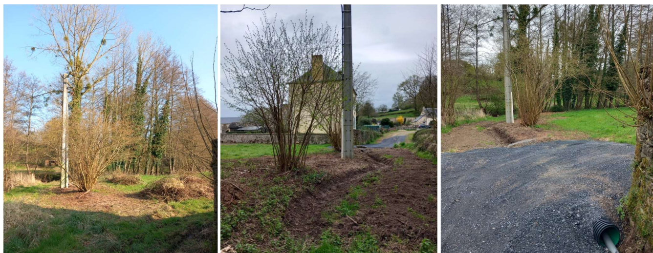
Busage dans la zone humide derrière le gîte et ajout de gravier à l'entrée du nouveau terrain communal
