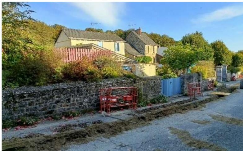
Les travaux pour le bouclage des deux transformateurs EDF ont débuté le 16 septembre et se sont poursuivis jusqu'à fin octobre. La route a été ponctuellement barrée en fonction de l'avancement des travaux qui se sont effectués par tronçons, au départ du haut du bourg jusqu'à la route de Saint-Jean-sur-Erve.
