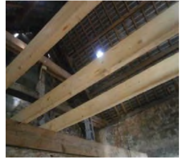
Travaux en cours
