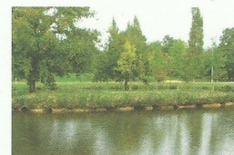
Dégâts sur berge
